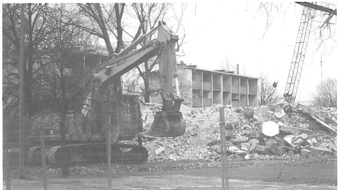
Häuserabriß auf der Altdeponie Dhünnau in Leverkusen
